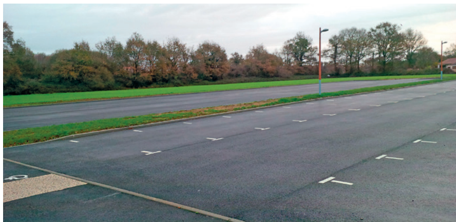
La réalisation d'un parking supplémentaire à la salle Socio-culturelle a été effectuée.
