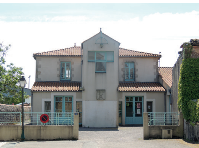
Rénovation de la salle polyvalente. (Salle du vieux couvent). La salle est fermée pour travaux de décembre à début avril.
